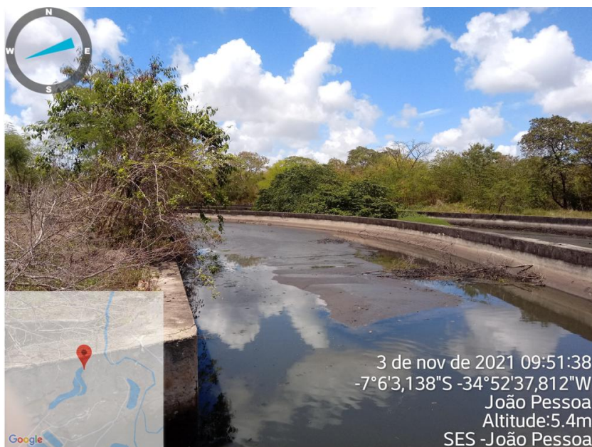
Figura 143 – Assoreamento no “S”
