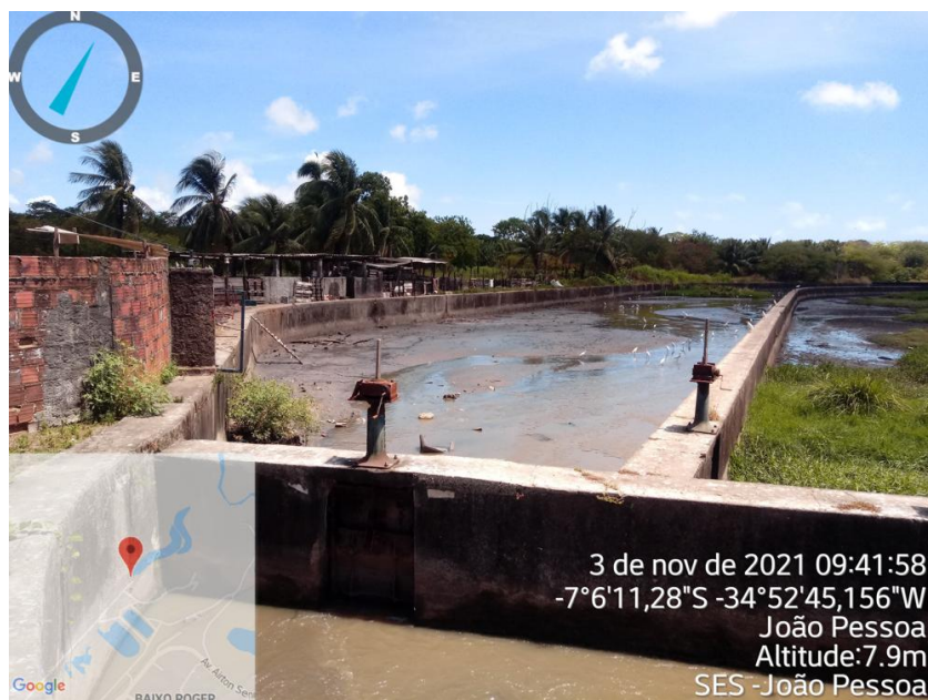
Figura 141 – Assoreamento no “S”
