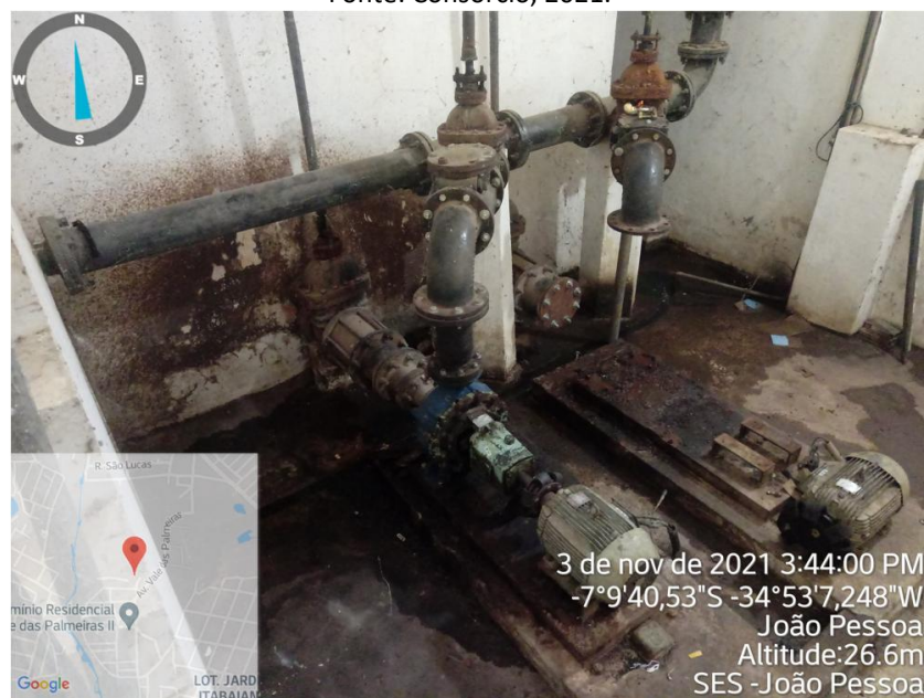
Figura 105 – Poço das bombas
