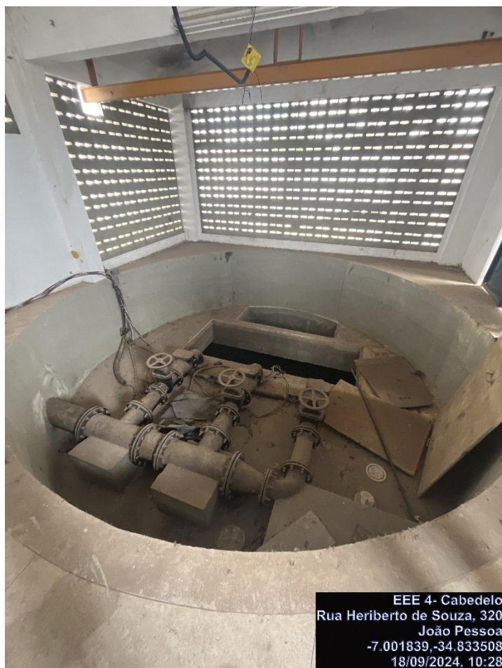
Figura 30 – Poço de Sucção e Barrilete- EEE 04.
