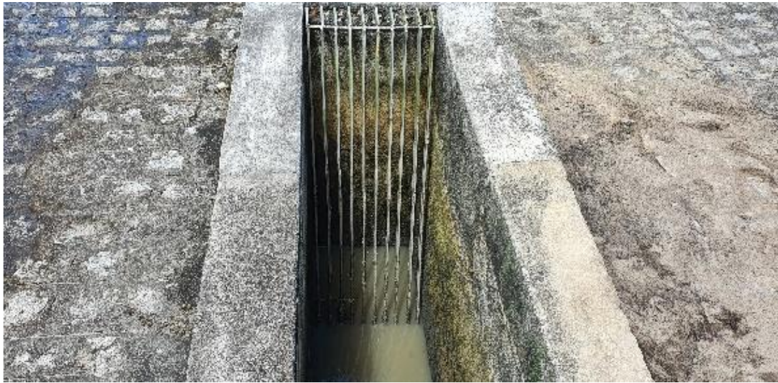
Figura 16 - Gradeamento EEEB 01.
