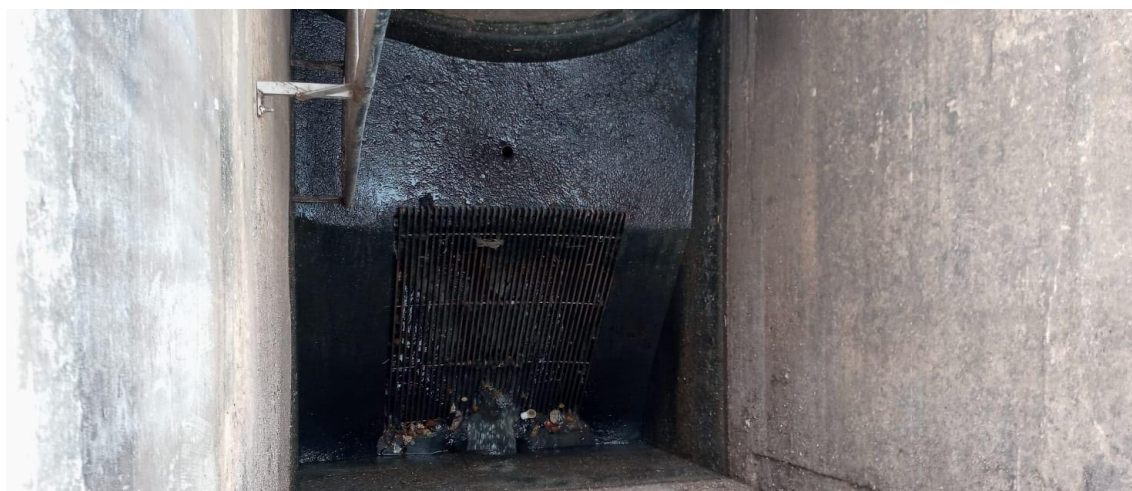
Figura 181 - Estação Elevatória de Esgoto, Tratamento Preliminar.
