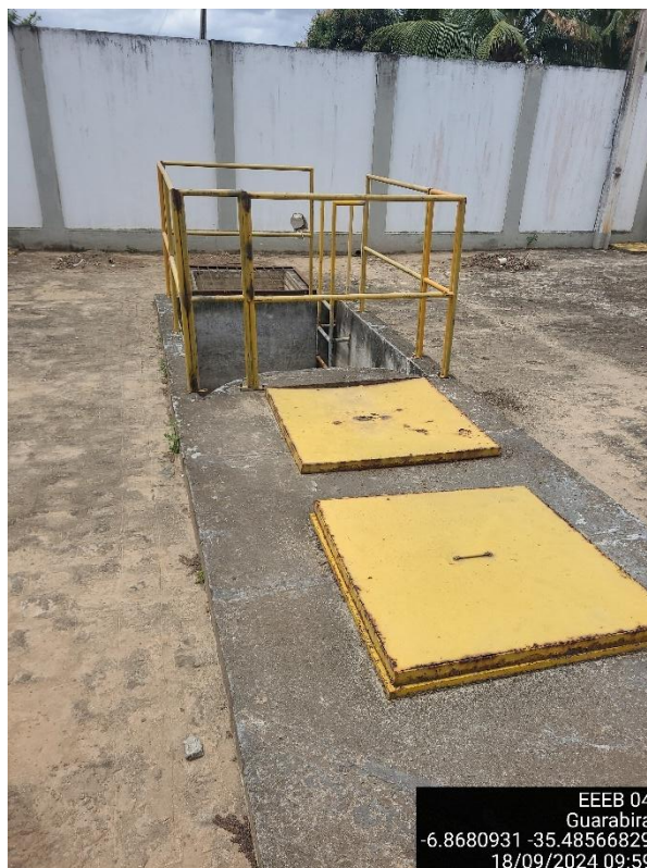
Figura 60 - Poço da Bomba Submersível – EEE-04.
