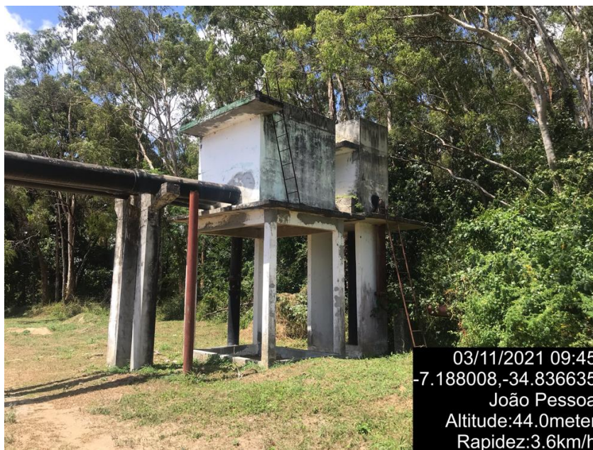
Figura 145 – Caixa de transição e distribuição de Esgotos Módulos I e II
