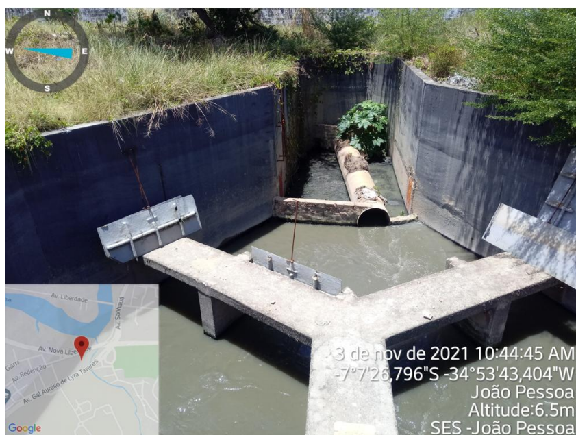
Figura 101 – Ausência de grade
