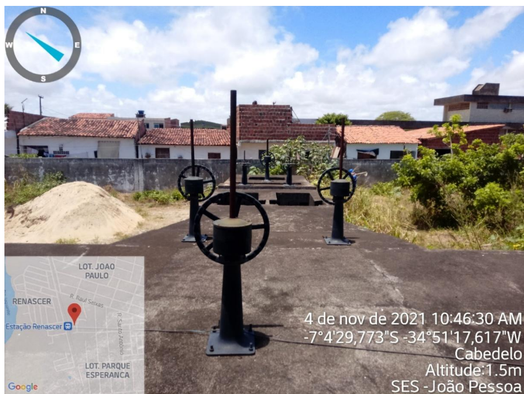
Figura 38 - Gradeamento, Caixa de Areia e Poço de Sucção - EEE 14.
