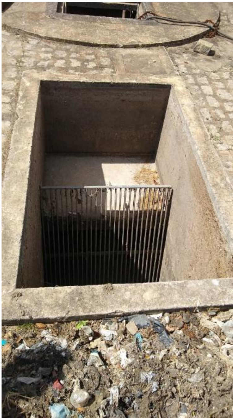
Figura 203 – Gradeamento EEE-03
