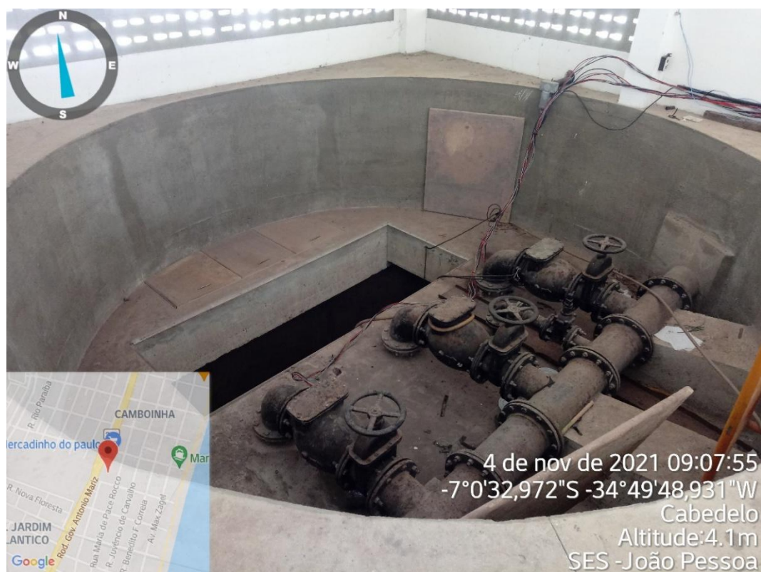
Figura 32 – Poço de Sucção - EEE 05.
