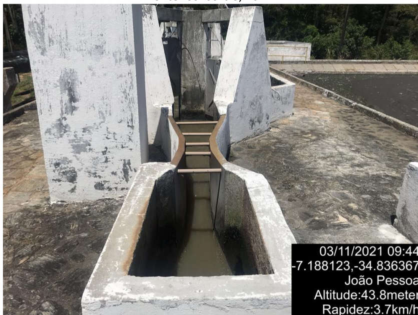
Figura 148 – Calha Parshall
