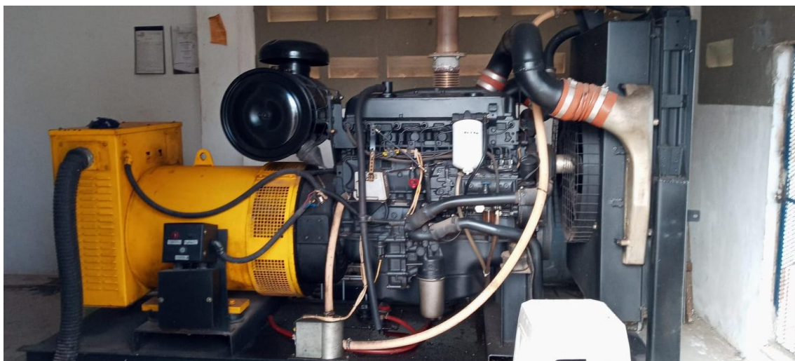
Figura 183 - Estação Elevatória de Esgoto, Gerador.
