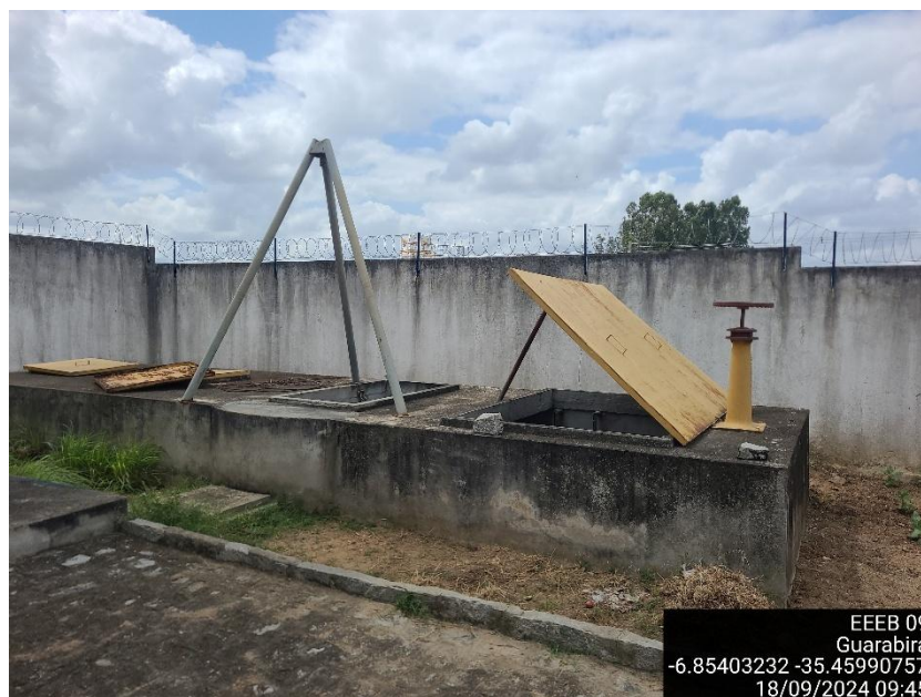
Figura 65 – Gradeamento e poço de Sucção – EEE-09.
