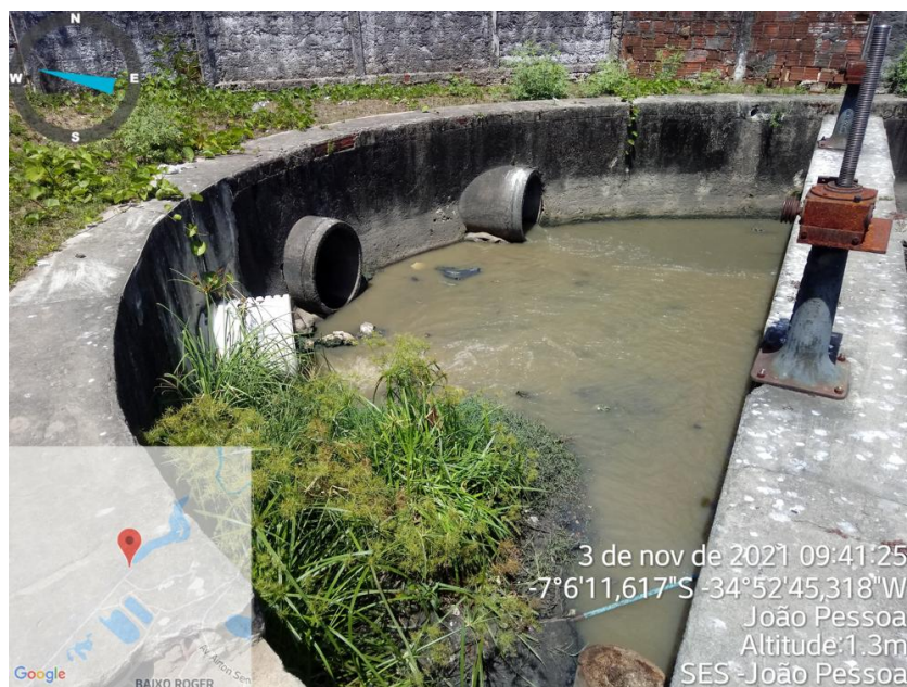
Figura 139 – Chegada 1 de esgoto no “S”
