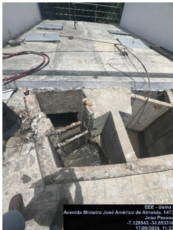
Figura 81 – Gradeamento e Poço de Sucção
