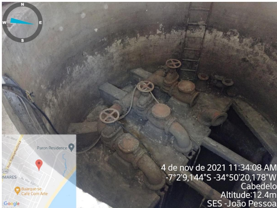
Figura 42 - Poço de Sucção - EEE Intermares 01.
