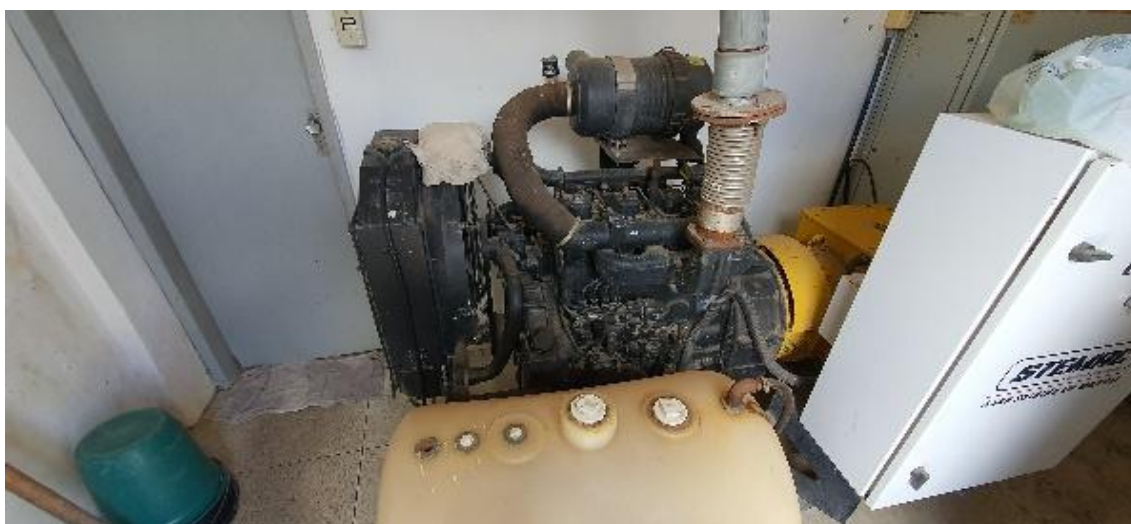
Figura 19 - Gerador de Energia Elétrica
