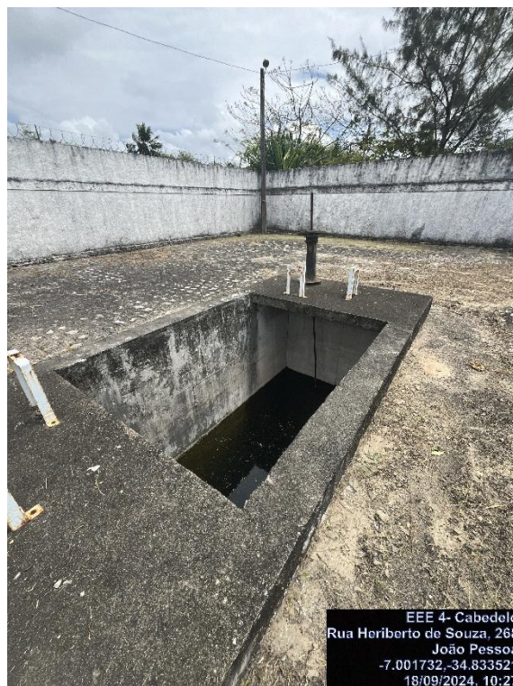
Figura 29 - Gradeamento e Caixa de Areia - EEE 04.
