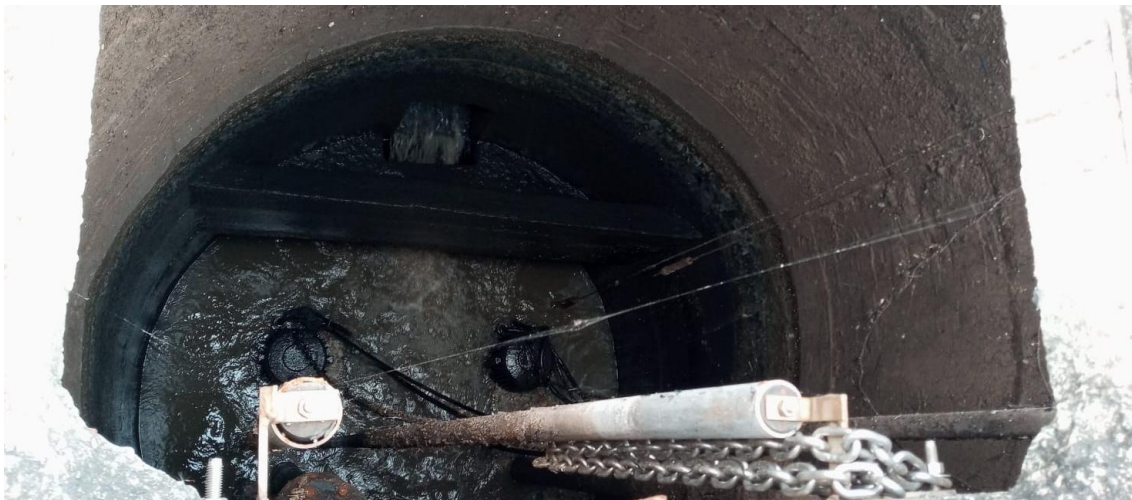
Figura 182 - Estação Elevatória de Esgoto, Bombas Submersíveis.
