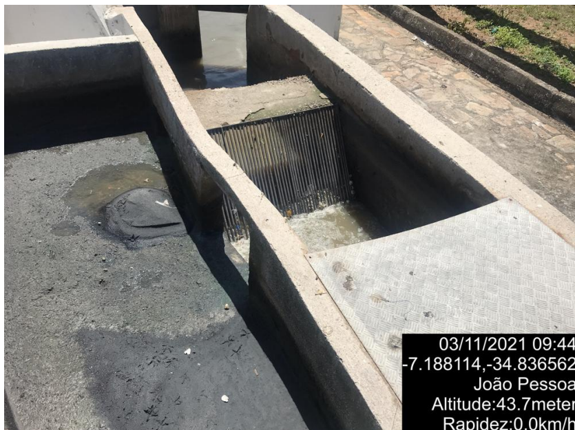
Figura 146 – Gradeamento
