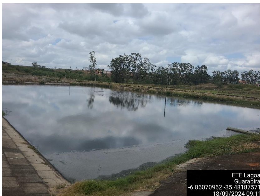
Figura 68 - Lagoa Anaeróbia ETE Guarabira.
