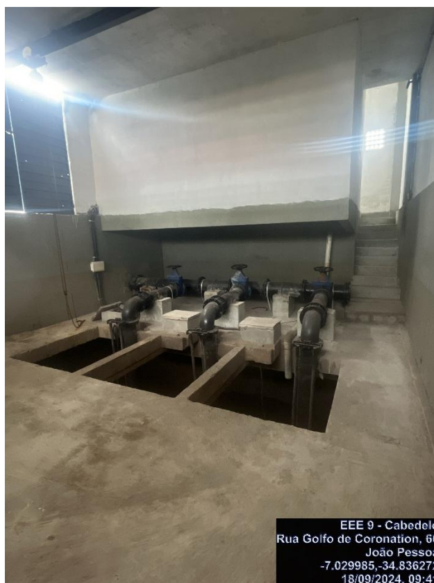
Figura 37 – Poço de Sucção e Barrilete - EEE 09.
