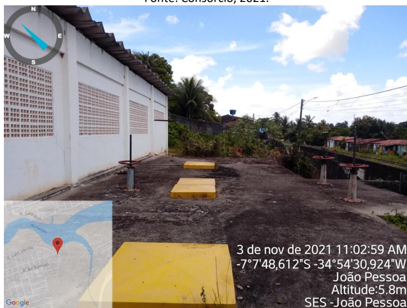
Figura 121 – Poço de sucção
