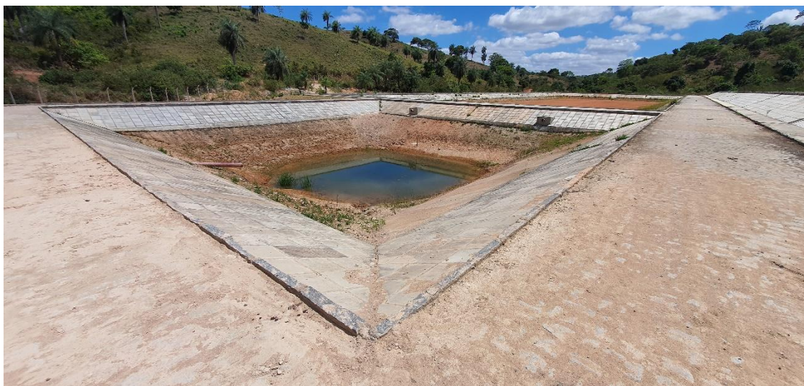
Figura 23 - Lagoa Anaeróbia e Facultativa ETE 01 em construção.
