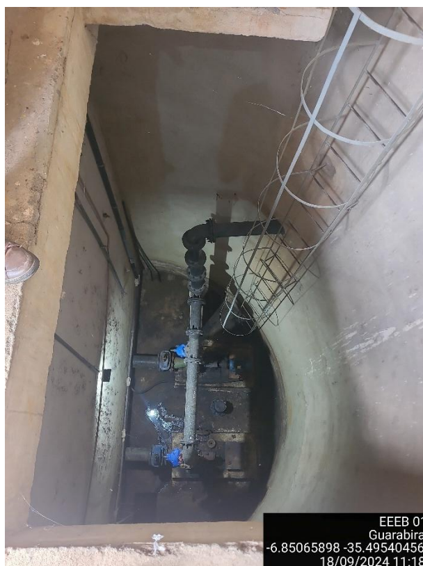
Figura 51 – Conjunto de bombas - EEE-01
