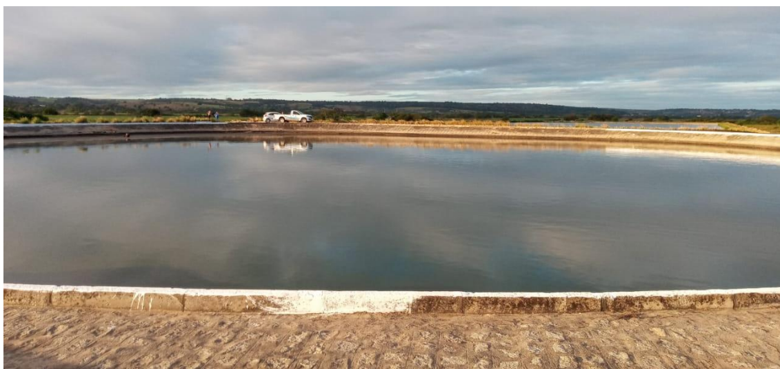
Figura 186 – ETE - Lagoa Anaeróbia.
