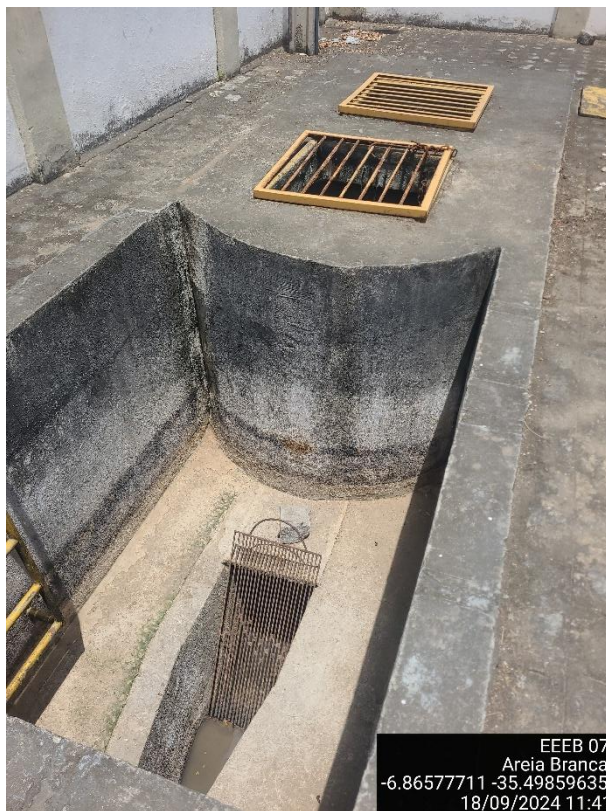
Figura 62 – Gradeamento e poço de sucção – EEE-07.
