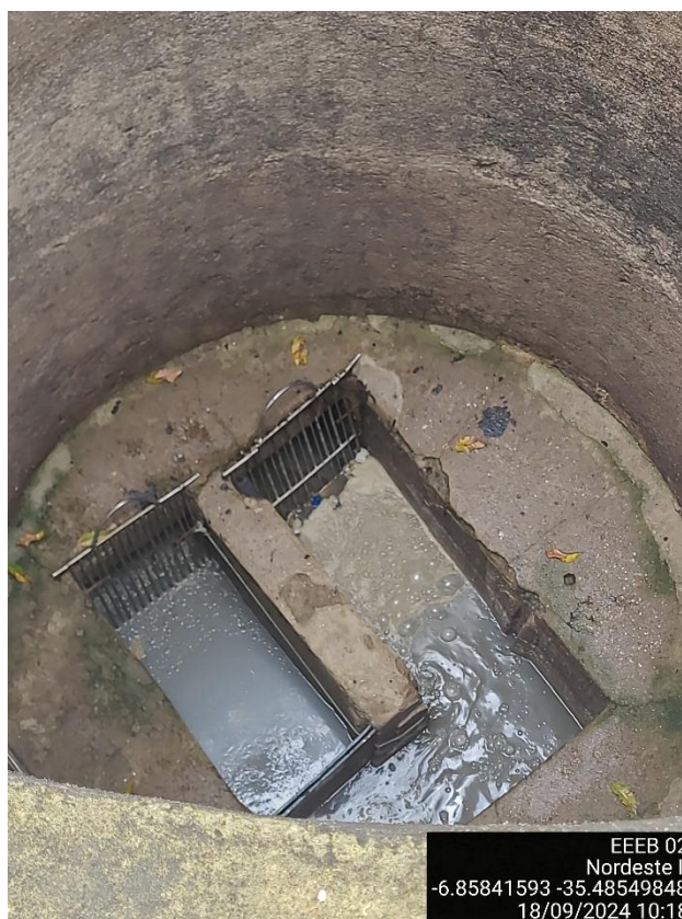
Figura 54 – Gradeamento - EEE-02A e 02B
