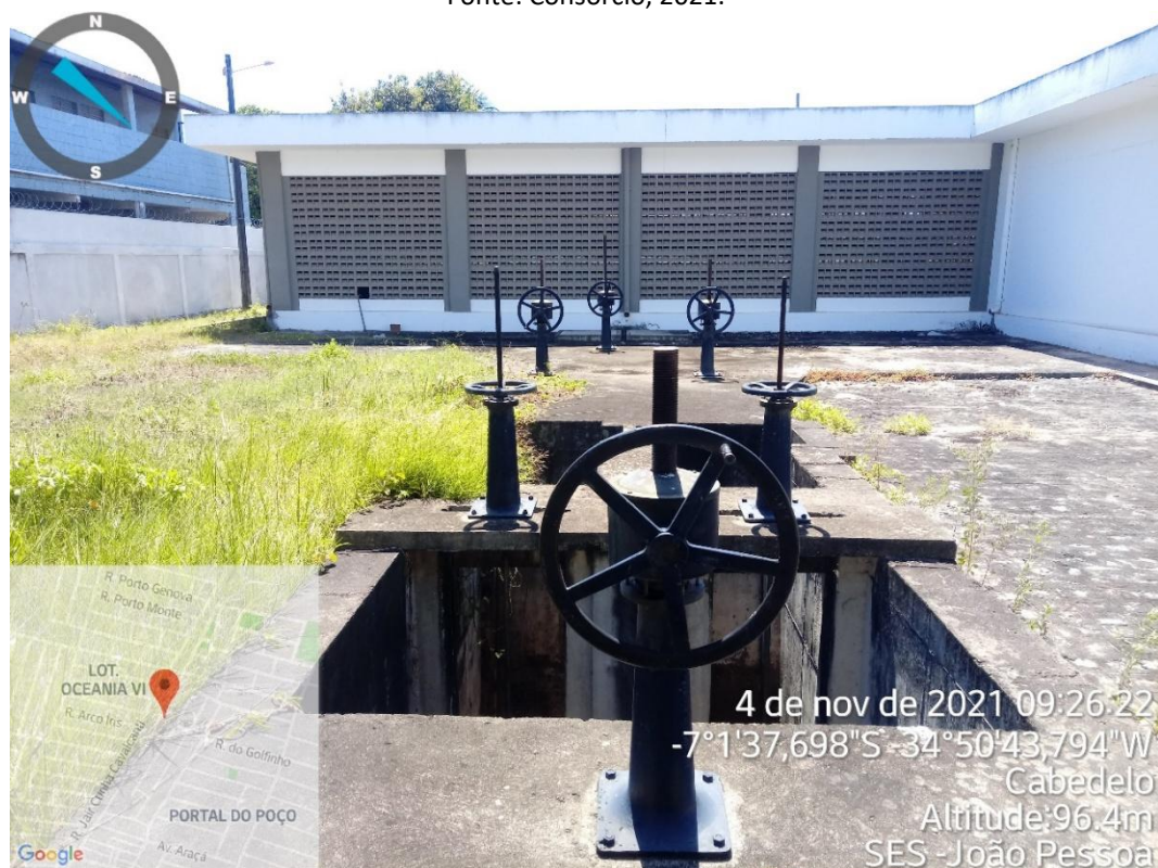
Figura 34 - Gradeamento, Caixa de Areia e Poço de Sucção - EEE 08.
