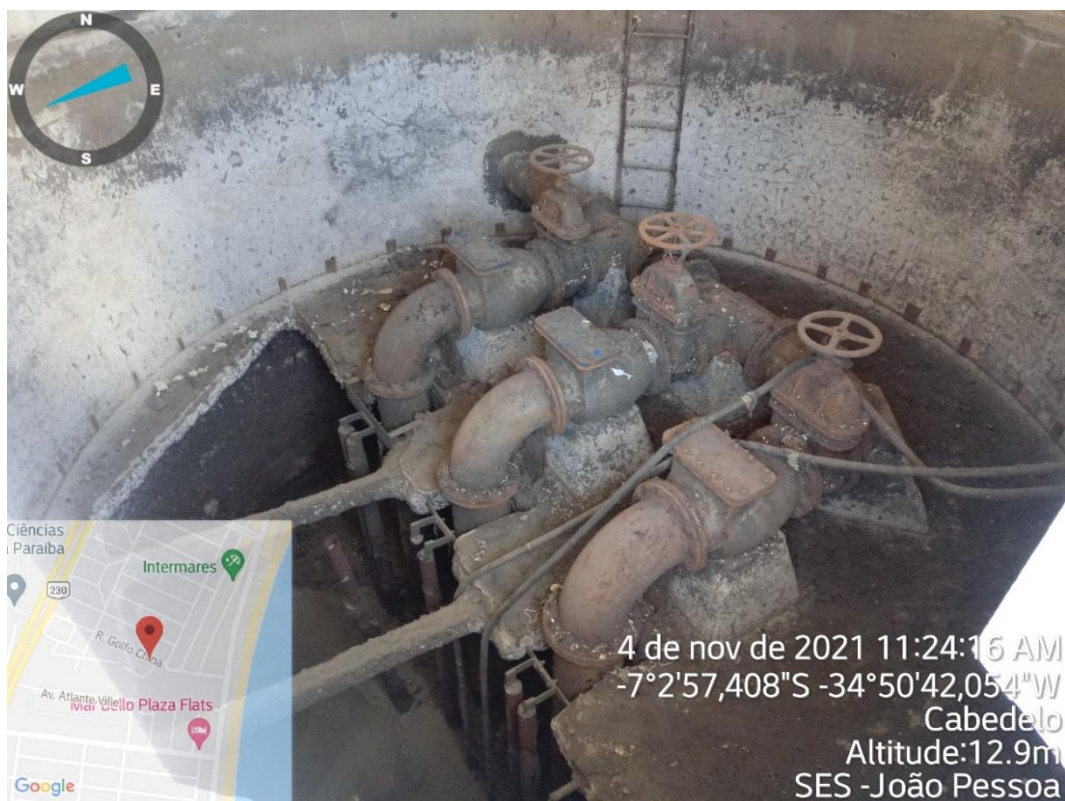
Figura 44 - Poço de Sucção - EEE Intermares 02.
