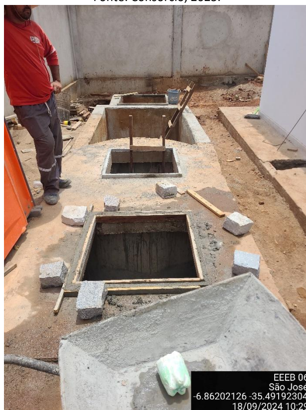
Figura 72 – Gradeamento e poço de sucção – EEE-06
