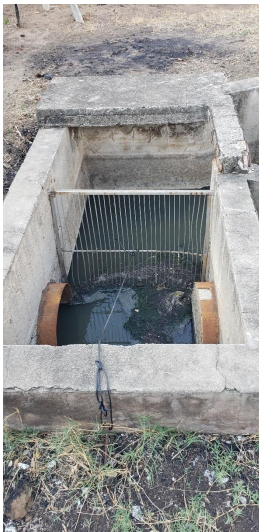
Figura 21 - Gradeamento na EEBB Final Fonte: Consórcio, 2021.
