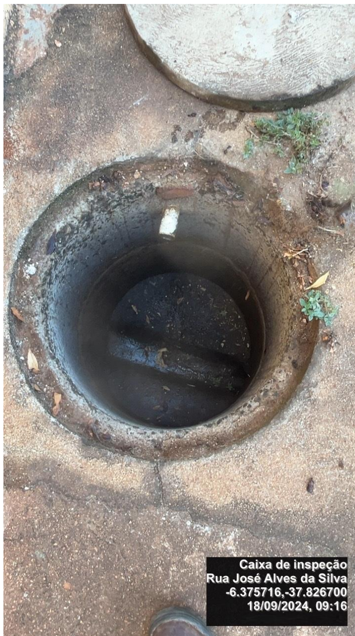
Figura 14 – Caixa de Inspeção Aberta.
