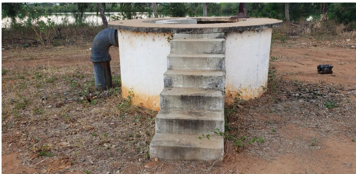
Figura 25 - Distribuidor do esgoto da Lagoa de Estabilização
