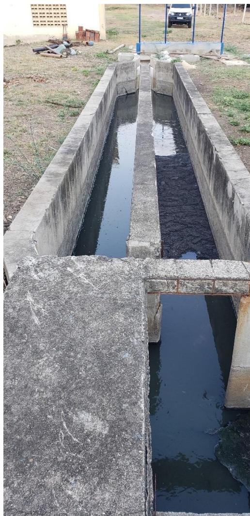
Figura 22 - Desarenador na EEBB Final Fonte: Consórcio, 2021.
