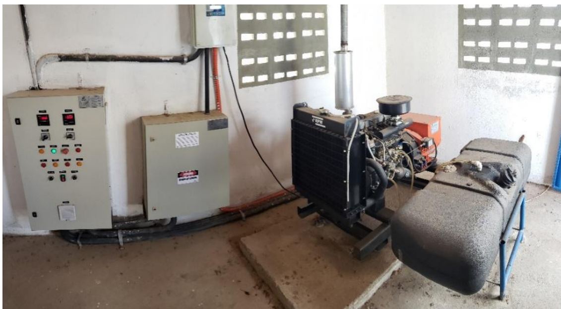
Figura 17 - Quadro de energia e motores da EEEB Residencial
