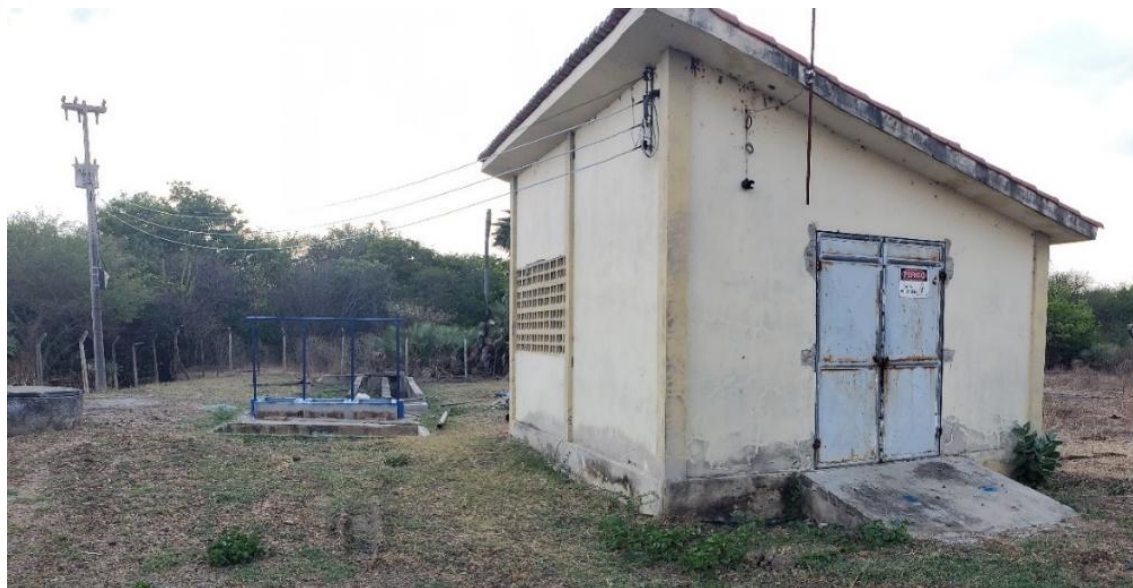
Figura 19 - Tratamento preliminar (ao fundo), conjuntos motobomba submersos (grade azul) e abrigo do gerador de energia (à esquerda)
