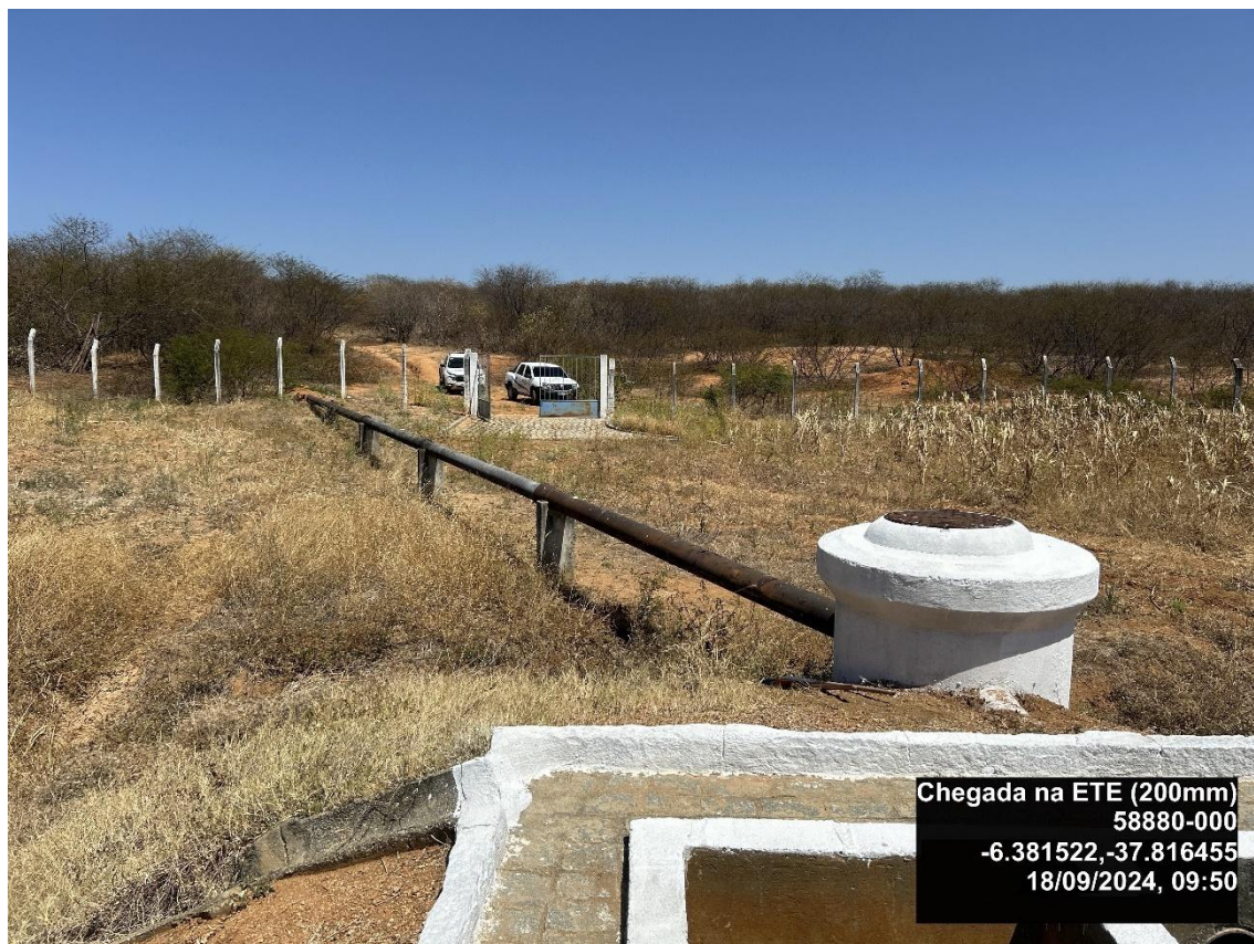
Figura 9 – Entrada da rede de esgoto na ETE.
