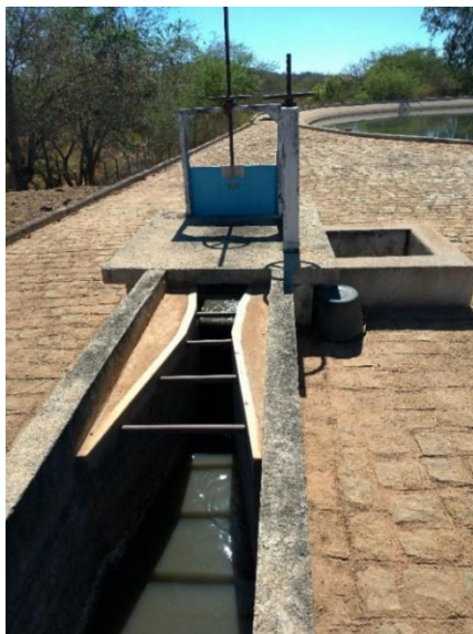
Figura 31 - ETE, calha Parshall.
