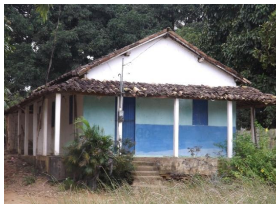
Pequena sede de fazenda em Pedras de Fogo. Casa em alvenaria com coluna em tubos de polietileno com massa/cimento no seu interior.
