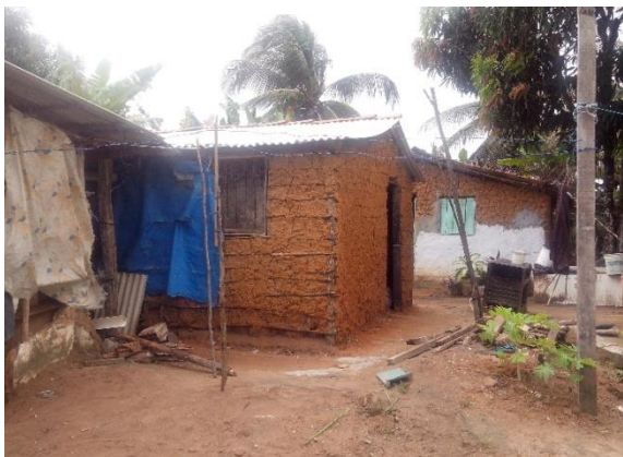
As edificações de Taipa de pau a pique, em toda região envolvendo as comunidades de retirada, Cupissura, Entre Rios e a zona rural dos municípios da AID tem essas características.
