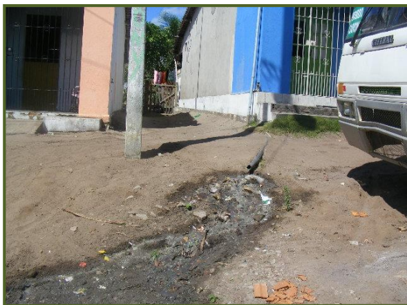
Lançamento de águas servidas a céu aberto - povoado de Cupissura
